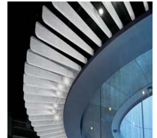
Panneaux acoustiques à lame verticaux Tectum personnalisés MD installés avec un profilé de montage en acier personnalisé
