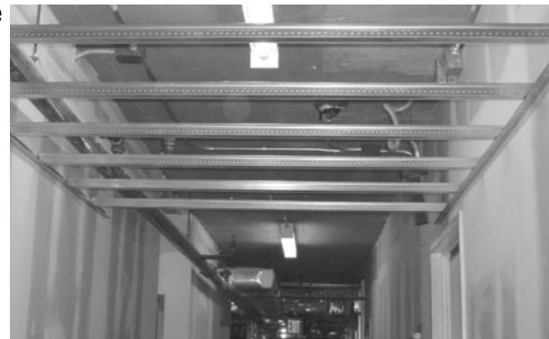
Le cadrage ShortSpan et la moulure à angle de blocage accélèrent et simplifient le cadrage pour panneau de gypse
