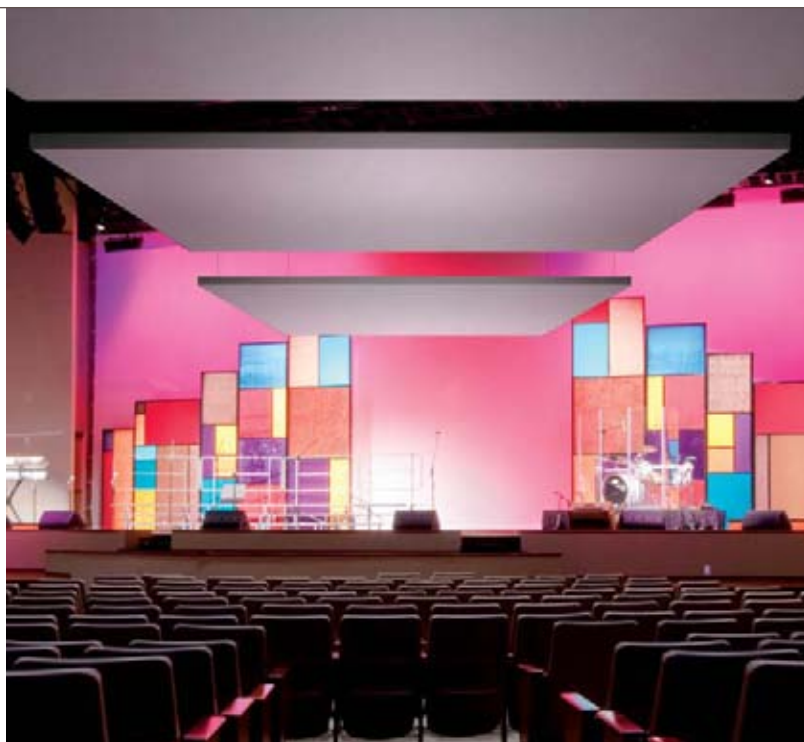
Formations con sistema de suspensión DGS para paneles de yeso – 10' x 14' con borde perimetral de una sola pieza Axiom de 6"
