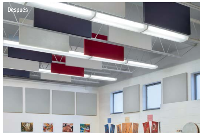
Baffles acústicos Soundsoak de 2' x 4' en telas FR-701; Paredes Soundsoak personalizadas de 3,5' x 3,5' con sustrato de fibra mineral y borde cuadrado en tela de color gris metálico FR-701
