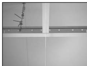
Aligner la deuxième ficelle de guidage avec le premier té croisé de quatre pieds
