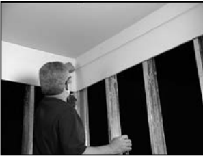
Marquer la hauteur désirée pour le nouveau plafond
