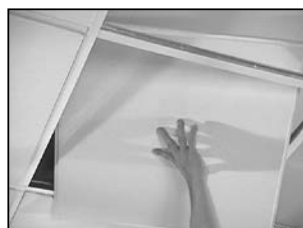
Pencher le panneau au-dessus du cadrage et l'abaisser en place.
