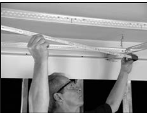
Équerer le treillis en mesurant les diagonales de l'ouverture du treillis
