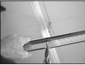
Installer les tés croisés de bordure
