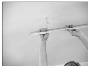
Installer le premier longeron principal
