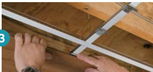
3 Positionnez les planches; faites glisser et fixez les attaches
