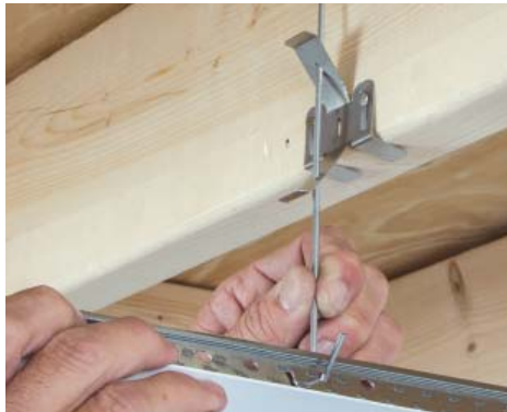
SUSPENSIÓN DE LAS TES PRINCIPALES CON ACCESORIOS DE SUJECIÓN QUICKHANG
