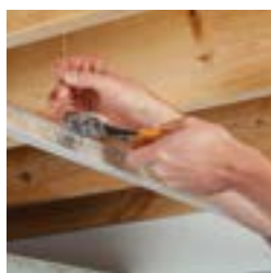
2 Suspendez les tés principaux avec les fils de suspension
