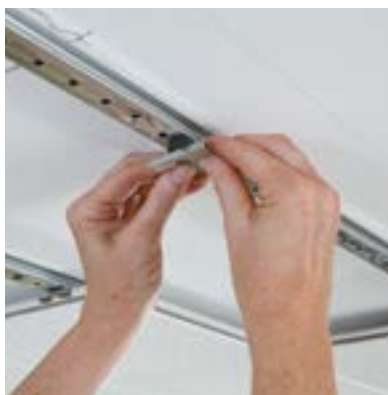
2 Fixez les attaches (modèles 1191 ou 1191SC)
