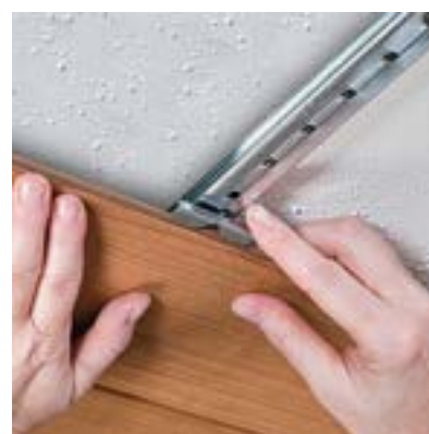
Pose des planches WoodHaven MD à l'aide des rails et des attaches Easy Up MD
