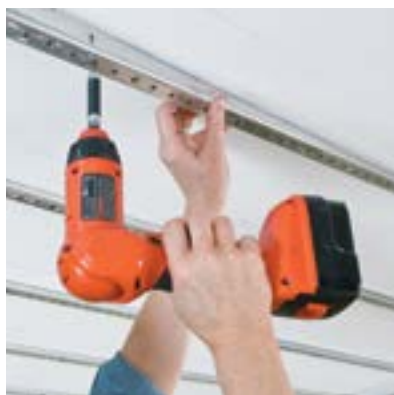
1 Attachez les rails (modèle 1190)
