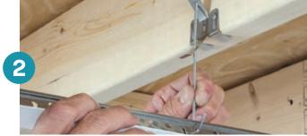
Suspenda las tes principales con alambre de colganteo o los accesorios de sujeción\* QuickHang™ (se muestran más arriba: ganchos y soportes QuickHang)
