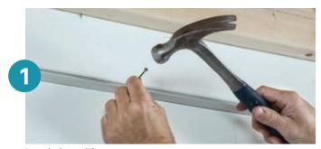
Instale la moldura para muro
