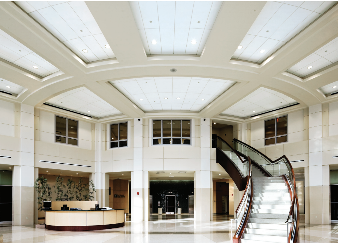
▲ Panneaux Optima Radial sur mesure avec système de suspension Prelude XL de 15/16 po sur mesure
