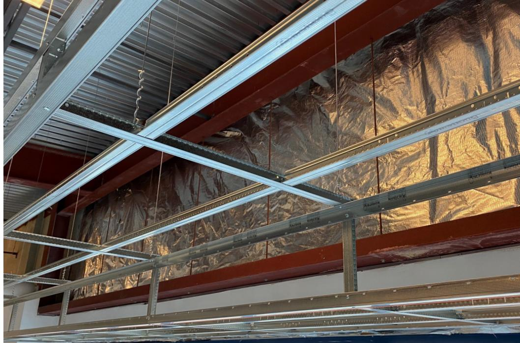
Le système de cadrage de retombée en gypse SimpleSoffit fait partie de la gamme de produits de la suspension à gypse FrameAll<sup>®</sup>
