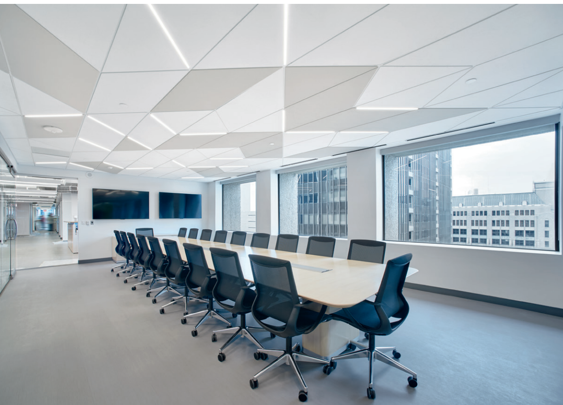
Panneaux Calla Formes avec système de suspension Suprafine MD XM de 9/16 po
