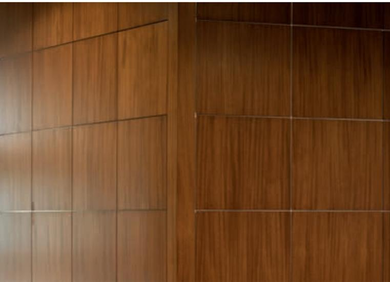
Le système mural Concerto<sup>MC</sup> de WOODWORKS<sup>MC</sup> comprend les extrusions d'aluminium interchangeable suivantes avec différentes options de taille de retrait, entre 1/8 po et 1 po. Le système Concerto de Woodworkds est offert en panneaux acoustiques pleins et microperforés, perforés et Encore<sup>MC</sup> 6, et en panneaux plats.
