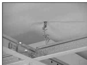
Il faudra peut-être ajouter des fils de suspension au treillis pour supporter le poids des appareils d'éclairage
