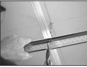
Installer les tés croisés de bordure
