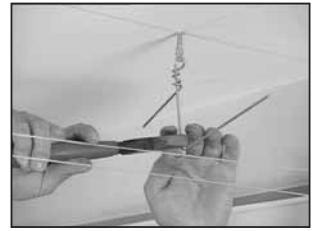
Plier les fils de suspension à la hauteur de la ficelle de guidage
