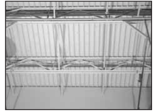
Les longerons principaux doivent être orientés perpendiculairement aux solives en barres ou en bois
