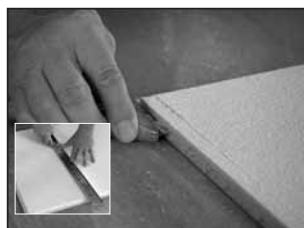
Il se peut que l'on doive couper les bordures régulières des panneaux de bordure. Les panneaux doivent être coupés face sur le dessus.
