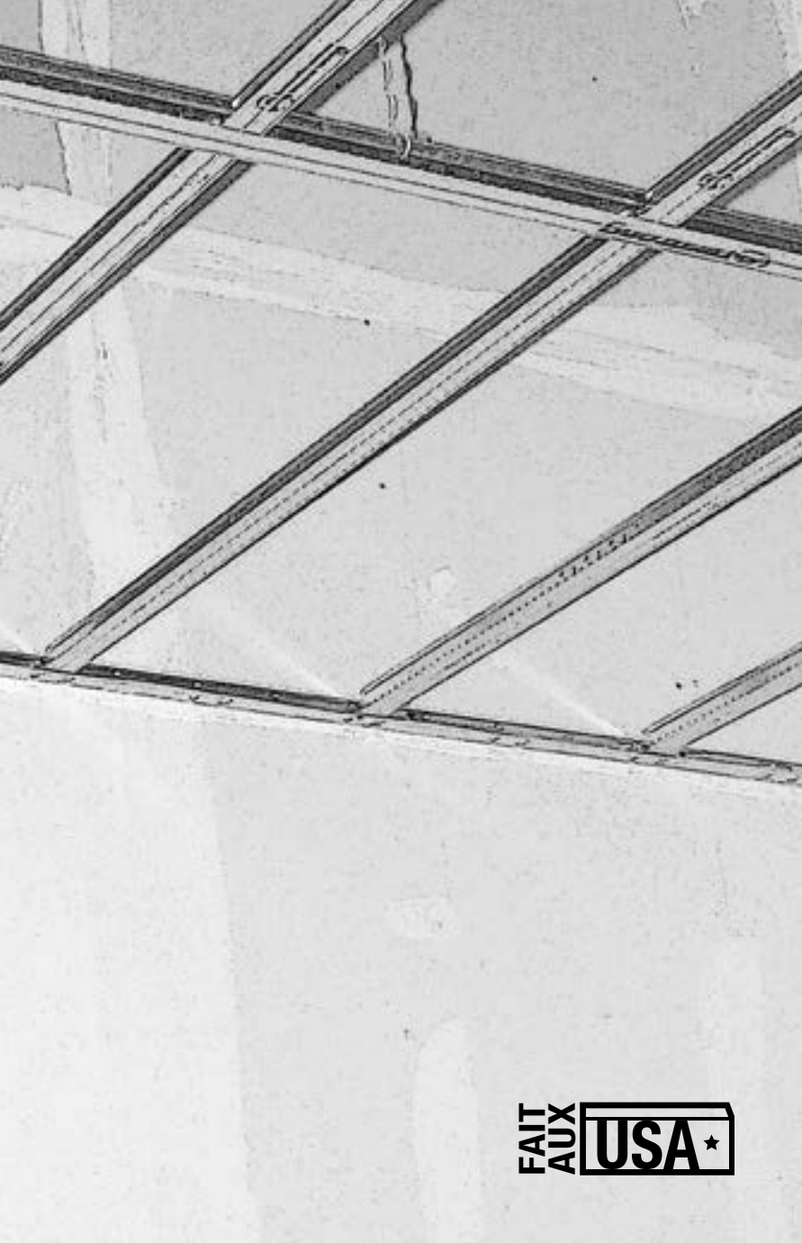
Installation de la suspension pour gypse plane
