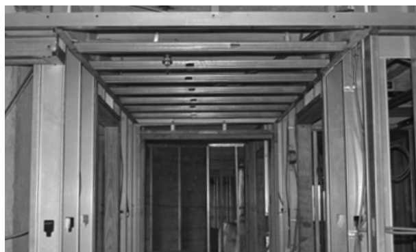
Cadrage de corridor avec des montants en acier traditionnels
