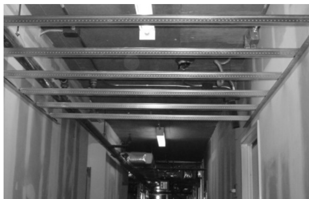
Le cadrage ShortSpan et la moulure à angle de blocage permet de créer plus rapidement et facilement le cadrage à gypse
