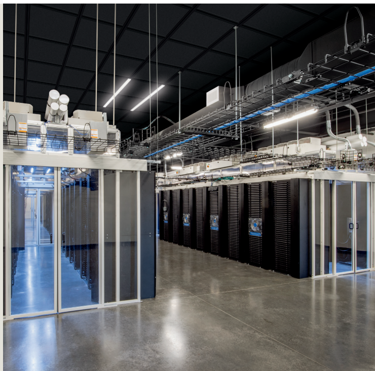
Installation d'une suspension structurale DynaMax MD Plus pour centre de données
