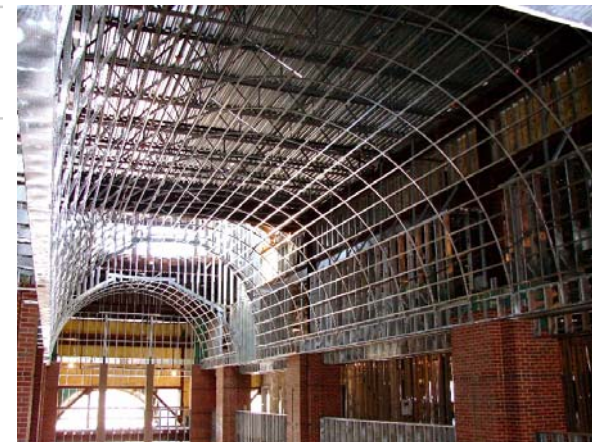
Voûte à cadre avec treillis à gypse
