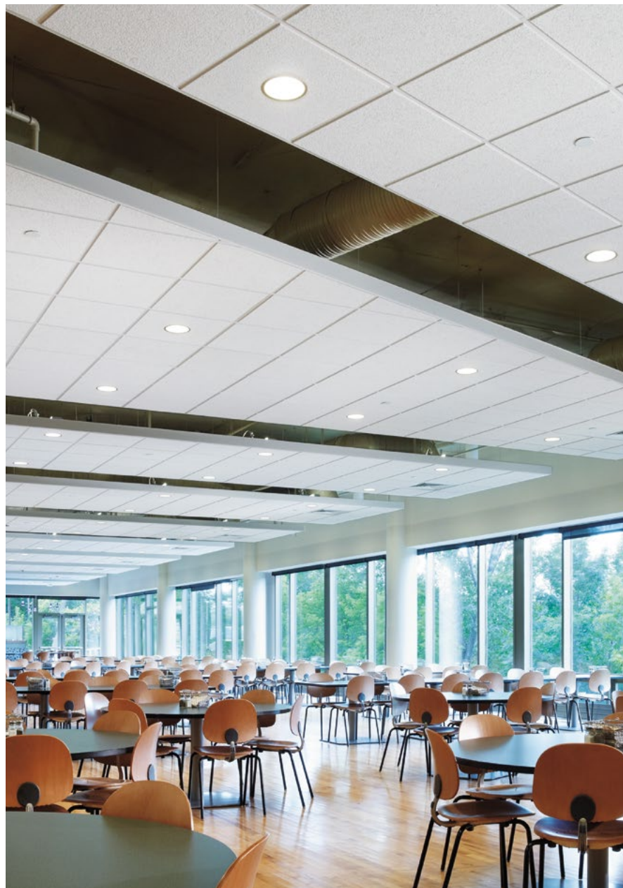
Panneaux de plafond Cirrus dans un système de suspension Prelude XL avec garniture Axiom Classique de 4 po
