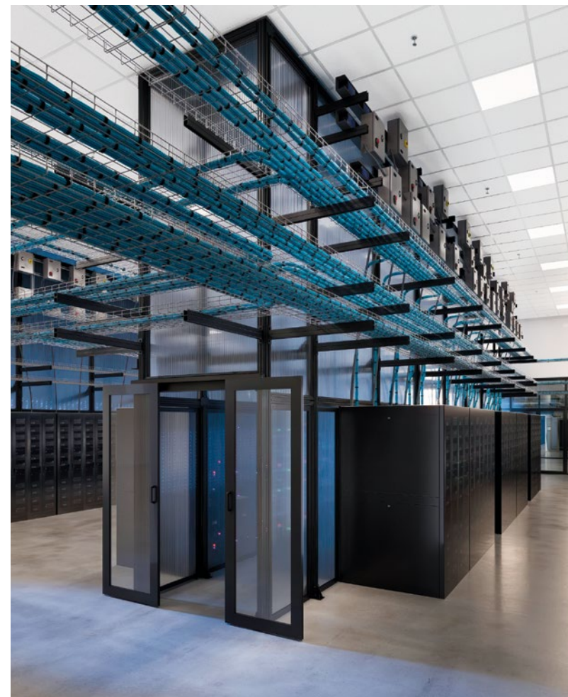
Confinement d'allée Armstrong ® avec structure Cool Shield ™
