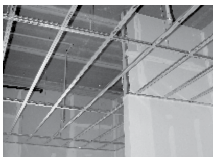
Suspension pour gypse FrameAll MD pour plafonds plats
