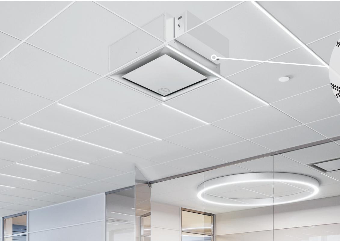
Sistema de filtragem de ar StrataClean IQ™ com painéis Ultima® Health Zone™ instalados no sistema de suspensão Suprafine® XL® de 9/16" (15mm)
