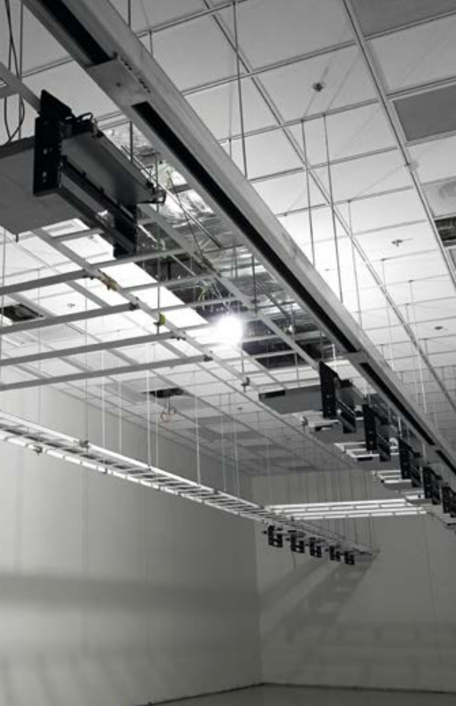
Instalación de centros de datos con el sistema de suspensión estructural DynaMax®
