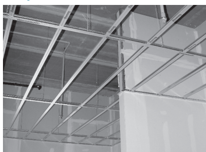
Sistema de suspensión para paneles de yeso FrameAll™ para cielos acústicos planos
