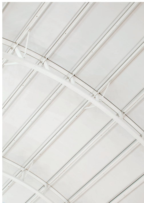
Sistema de plafones curvo personalizado MetalWorks™ Torsion Spring tableros de 30" x 82" con perforación Rg 2516 en acabado Cream Weave
