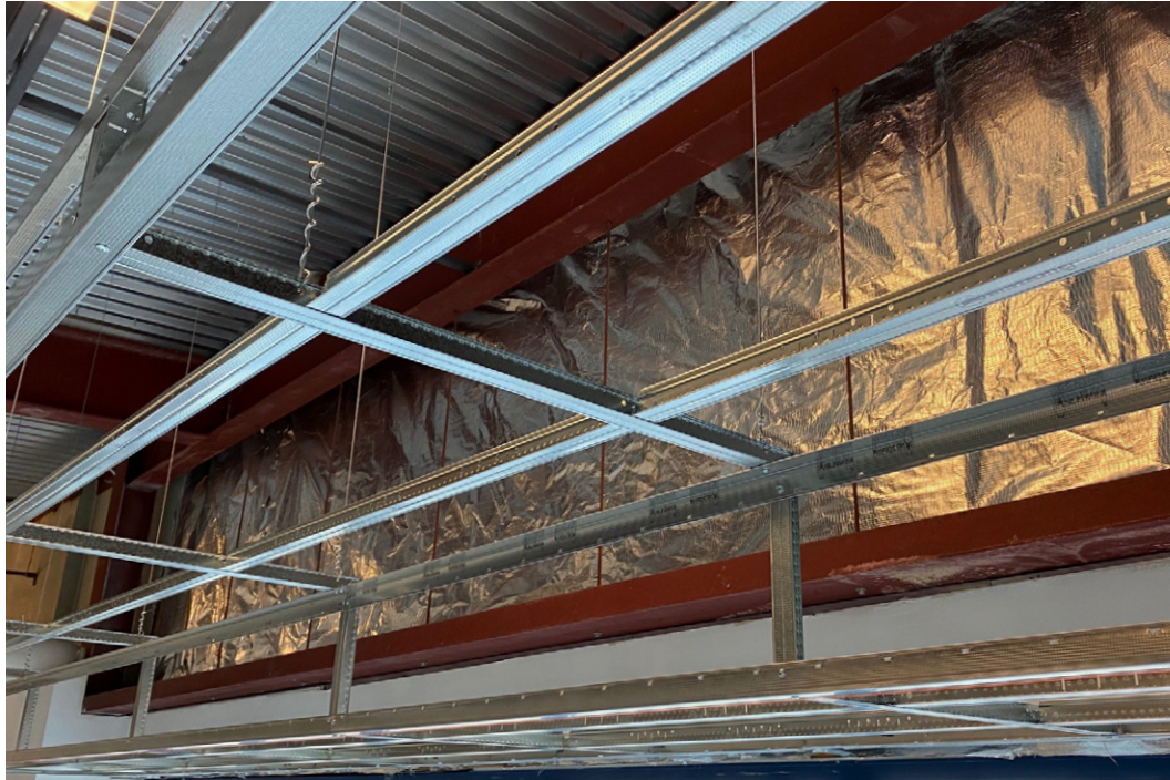
Sistema de entramado de cajillos para paneles de yeso SimpleSoffit, parte de la familia de productos de sistema de suspensión para paneles de yeso FrameAll®
