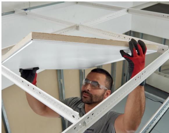
Plafón MetalWorks Tegular con plafón de relleno acústico Calla® 2820 – Sistema de plafón Total Acoustics™
