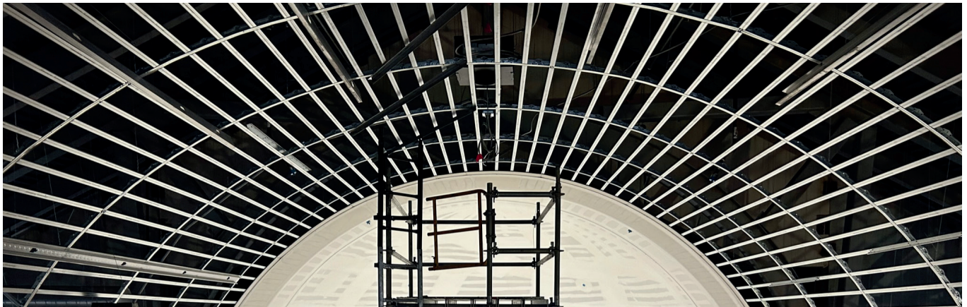
Sistema de suspensión para panel de yeso facetado para paneles de yeso curvos
