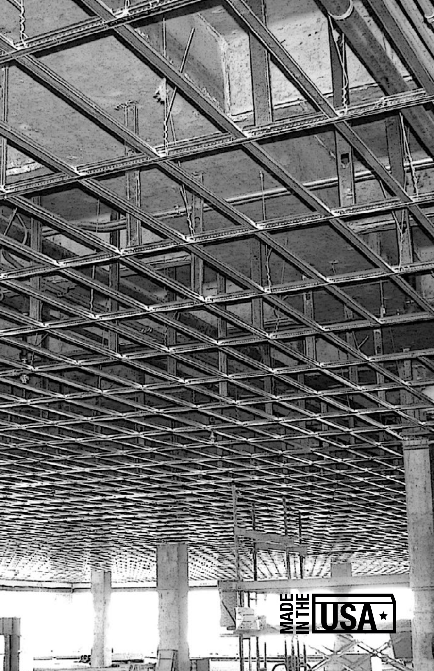
FrameAll™ Drywall Grid Installation
