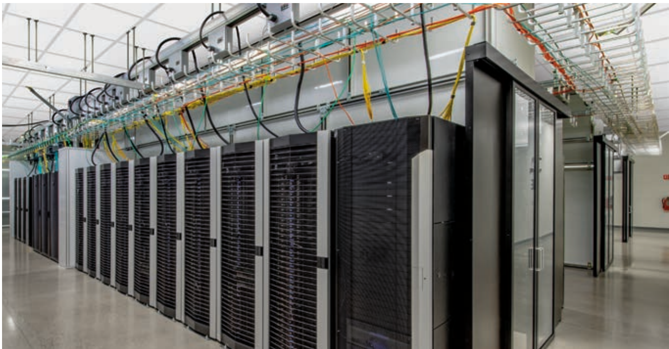
Sistema de suspensión de aluminio estructural para centros de datos DynaMax y Calla® para DynaMax
