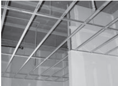
Sistema de suspensión para paneles de yeso FrameAll™ para plafones planos
